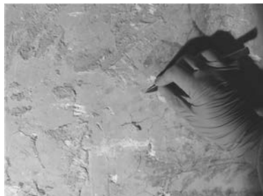
1. Detalle del proceso de restauración: limpieza mecánica.
